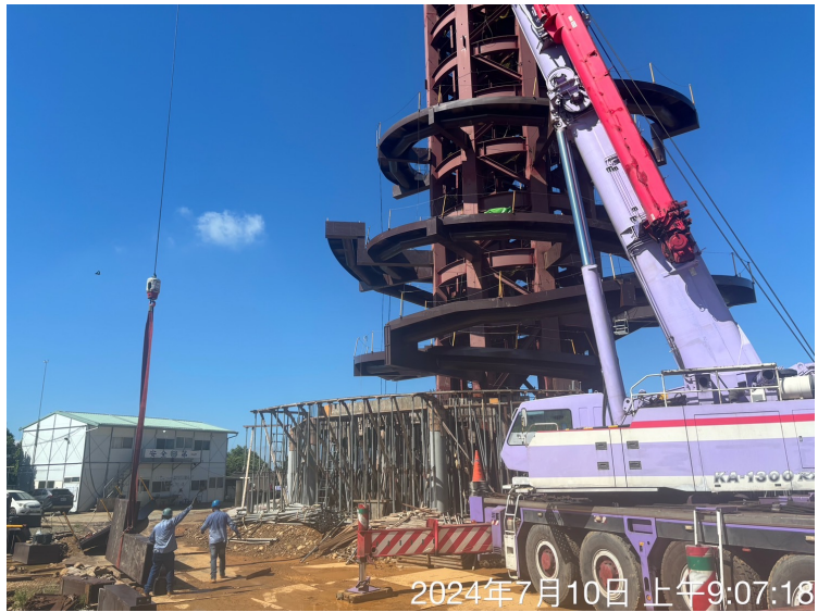
名間鄉松柏嶺高空觀景平台鋼構吊裝作業
