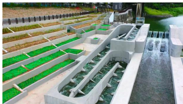
碧潭堰豎槽斜隔壁水池式魚道
