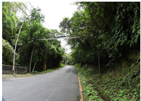
土城區承天路農路改善及空中生態廊道
