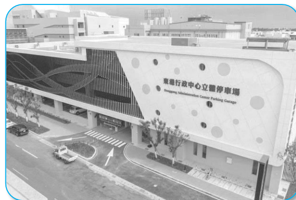
東港行政中心立體停車場
