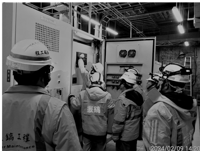
圖 1 113 年 2 月 9 日第一航廈停電事故修復現場
