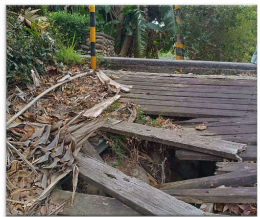
圖 1 自行車道設施損壞情形
