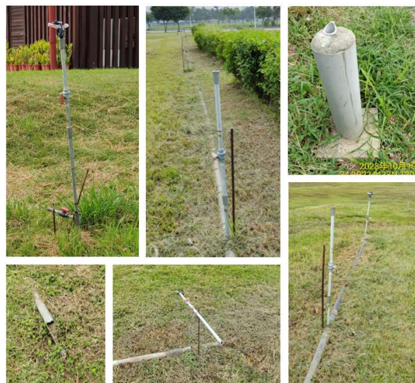
圖 1 噴灌系統固定鐵條外露及管線破損
