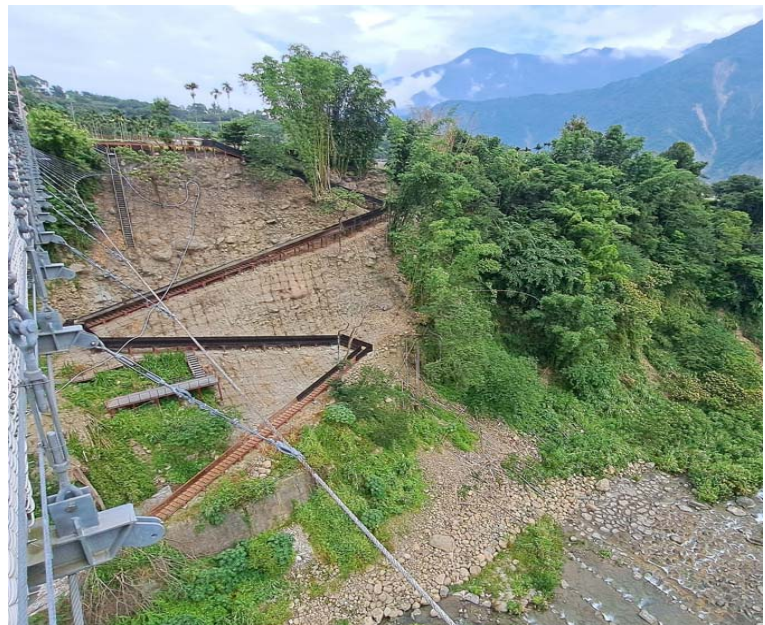
環境美化工程完工之棧道及施工中之噴漿工程
