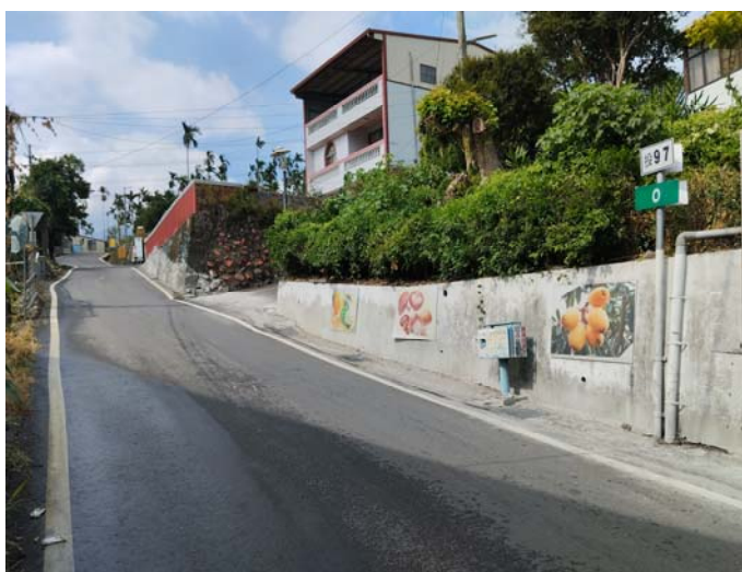
國姓鄉投 81 線 0K+000 處道路舊編號標誌
