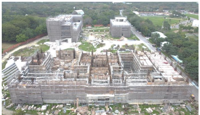
布袋戲傳習中心興建工程施工情形
