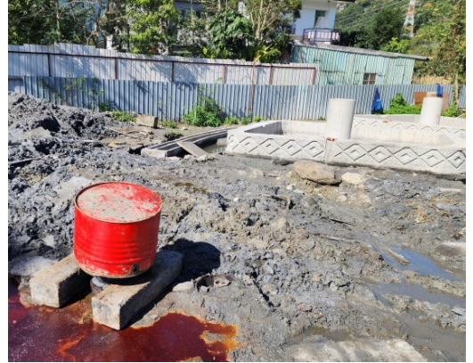
萬榮溫泉鑿井及附屬設施工程停工情形
