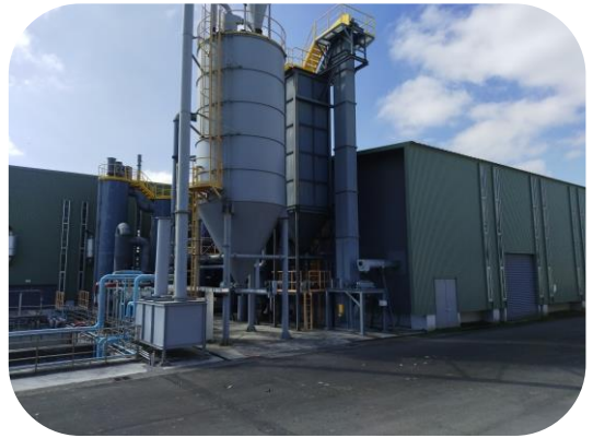
外埔綠能生態園區附屬設施
