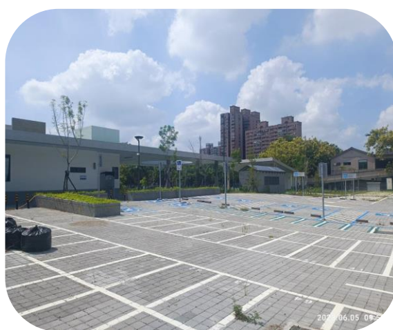
北屯區舊社停車場立體化興建工程
