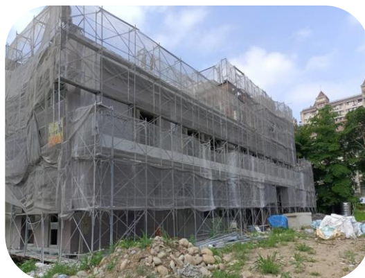
第三分局合作派出所 112 年 5 月施工情形
