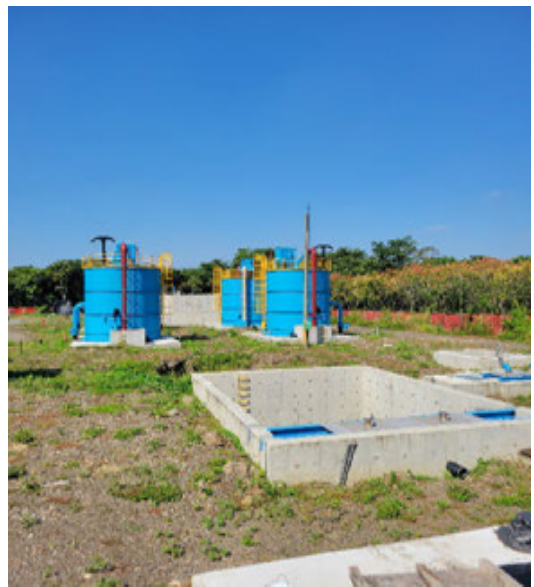
圖 4 屏東縣萬巒淨水場施工情形
