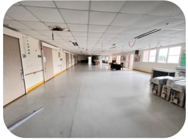
臺南市立長青長照機構3樓失智專區閒置
