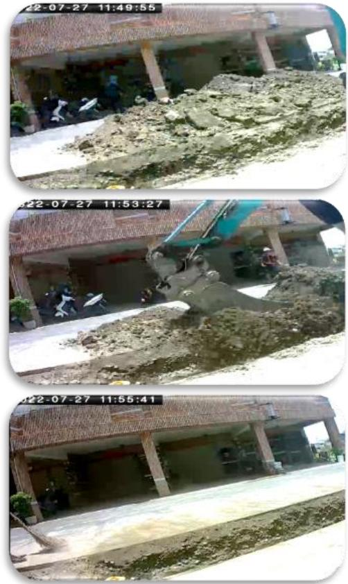
以原開挖土方作為回填材料施工情形
