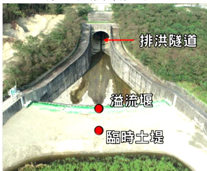
圖 1 阿公店水庫排洪設施
